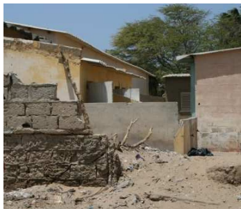
Servicios antes de la construcción
